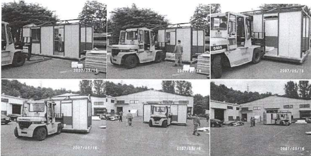
<그림 3.12> 조립과정 중 컨테이너 이동
